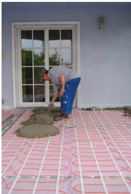
Heizmatte im Wintergarten unter dem Estrich verlegt
